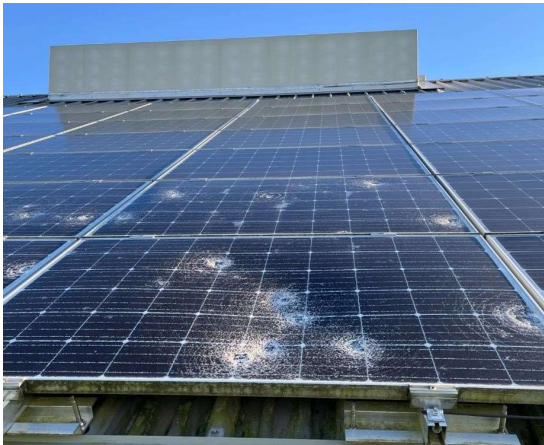
Sichtbare Schäden durch Glasbruch
